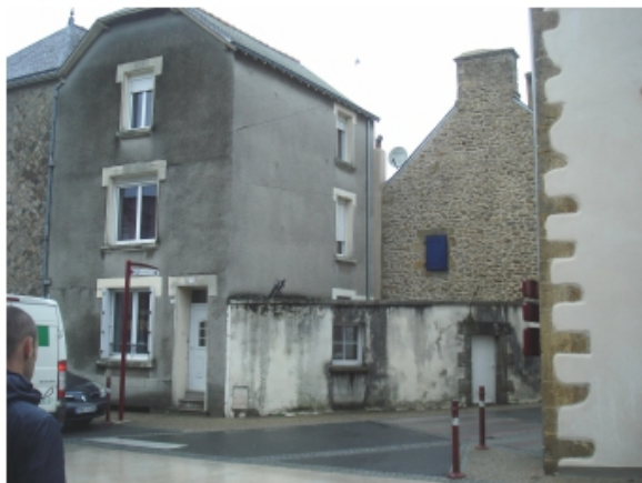
Photo état existant
