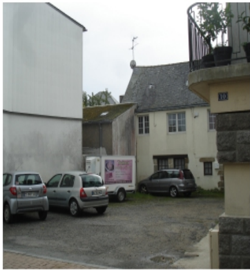
Photo état existant
